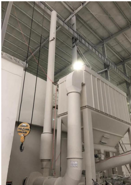
超细粉磨脉冲布袋除尘器
