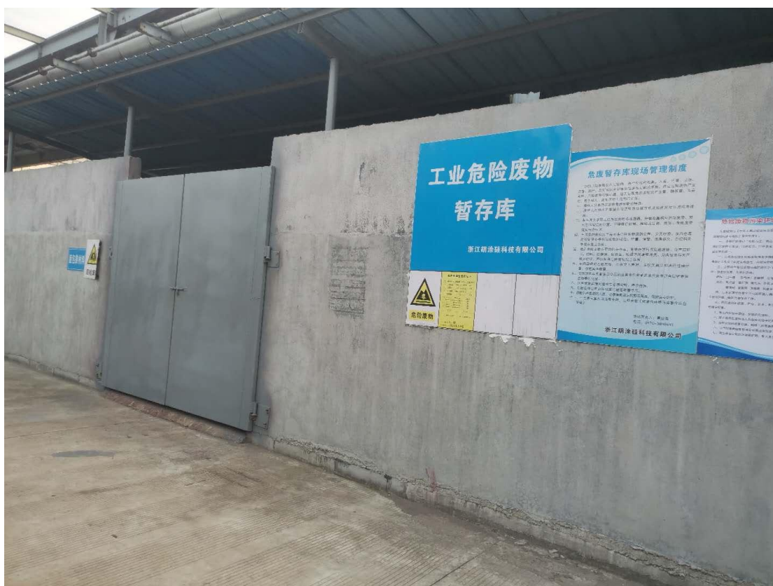
危废暂存间现场照片
