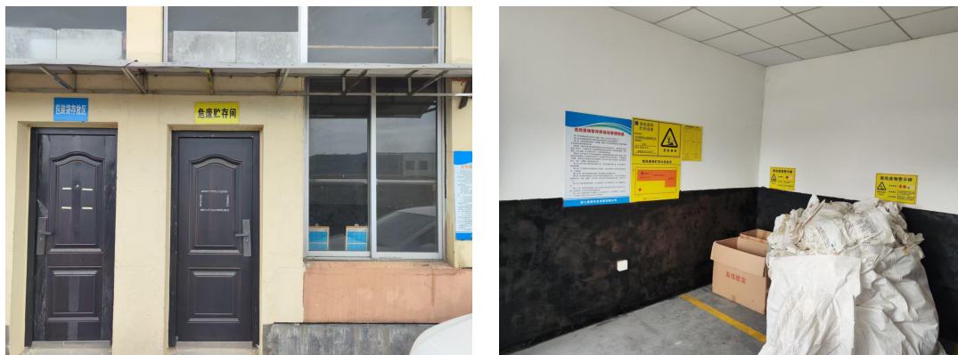
图4-5 项目危废暂存间
