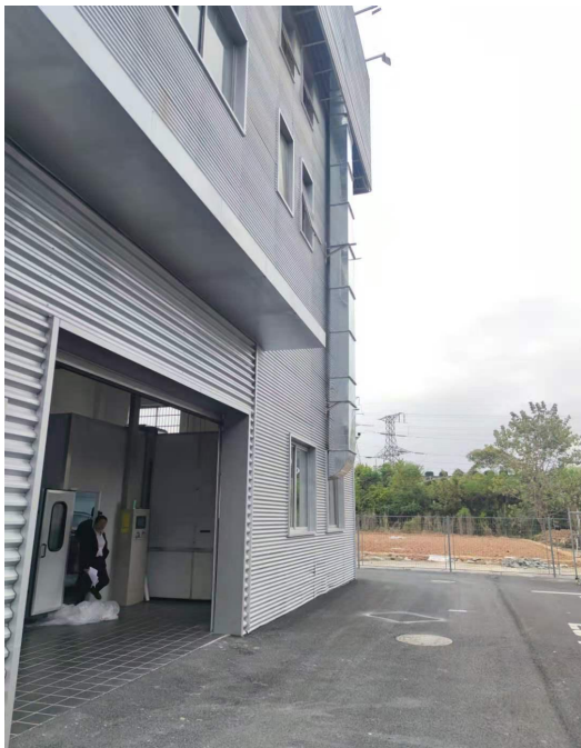
喷烤漆废气处理设施
