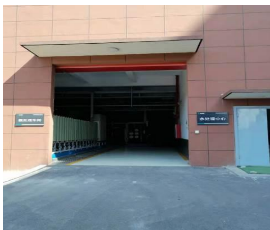
渗滤液处理站
