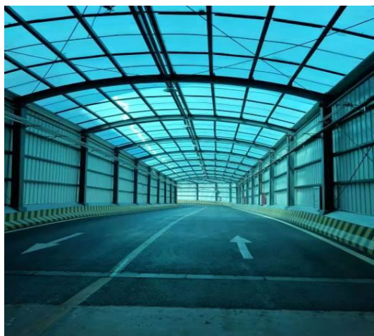
垃圾运输廊道
