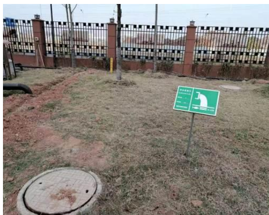
生活污水排放口
