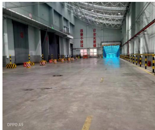
垃圾卸料大厅
