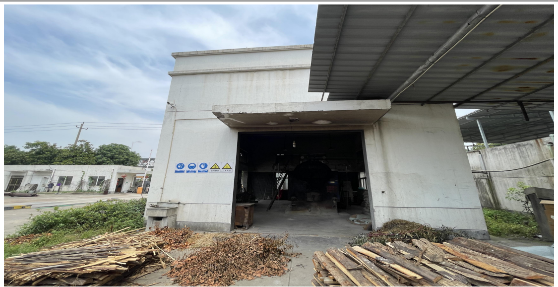
锅炉房，柴油发电机
